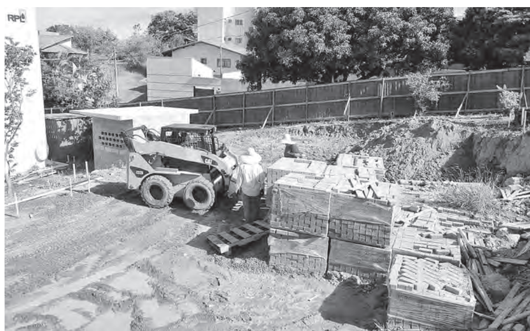
PISO INTERTRAVADO. O trabalho de assentamento prosseguiu durante a semana
