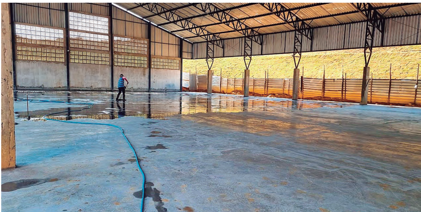
MUITO TRABALHO. As equipes dividem-se na montagem das estruturas metálicas e serviços de acabamento
