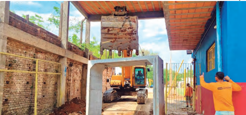
OBRA NA AAP. A Prefeitura está trabalhando para resolver um antigo problema: o alagamento do Estádio Dr. Julien Fouque (A. A. Portofelicense). A obra é a continuidade da canalização do córrego Pinheirinho e também está sendo feita com aduelas, aquelas grandes estruturas pré-fabricadas de concreto. As aduelas começaram a ser colocadas nesta semana.
