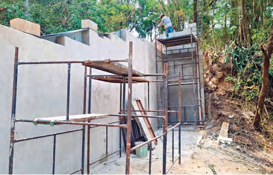
MURO DE ARRIMO. Uma das melhorias em andamento no Parque das Monções
