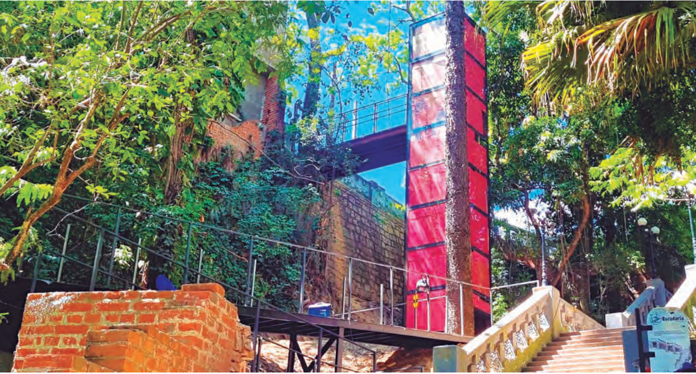
ELEVADOR PANORÂMICO. A rampa de acesso recebeu nesta semana os corrimãos, em nota etapa da obra
