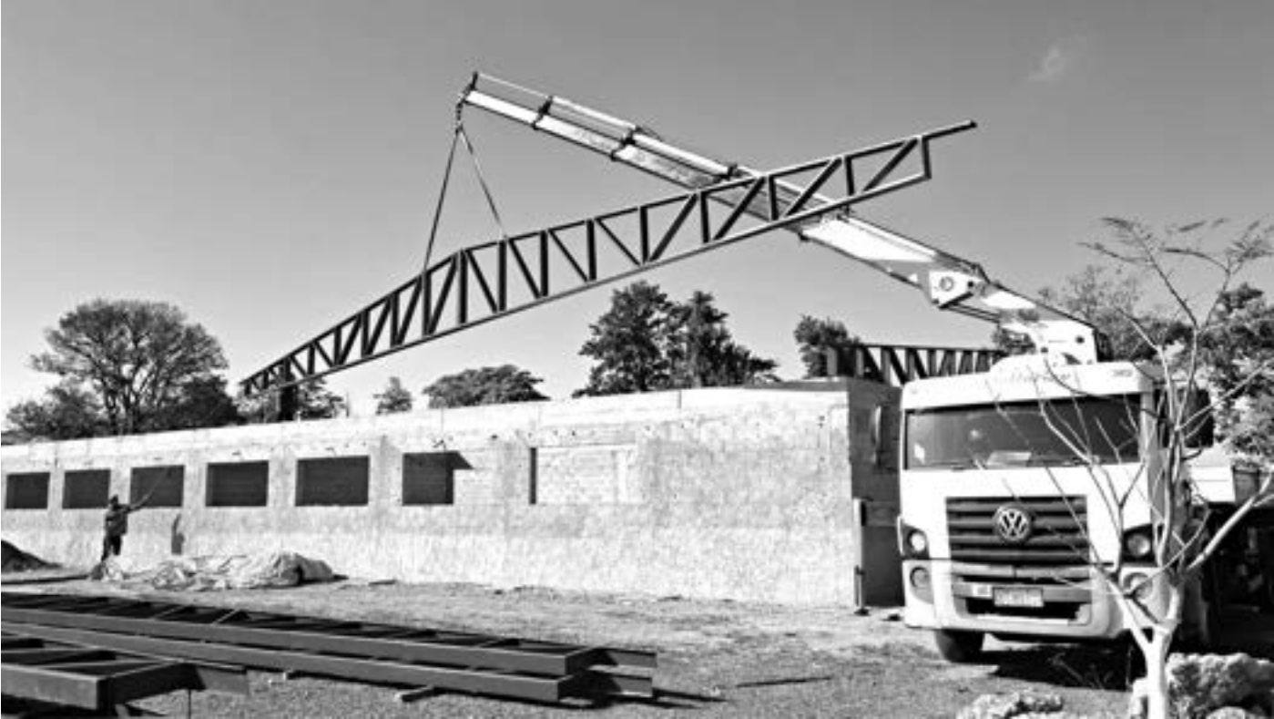
ESTRUTURAS INSTALADAS. O trabalho na escola municipal do Bom Retiro está avançando. Nesta quinta-feira (24) foram instaladas as estruturas metálicas que vão sustentar a cobertura da nova ala construída pela Prefeitura. A escola Profª Maria Aparecida Fernandes Leite terá seis novas salas de aula, uma moderna biblioteca e sala de fanfarra. A cozinha também está passando por uma ampla reforma, e os sanitários estão sendo modernizados.
