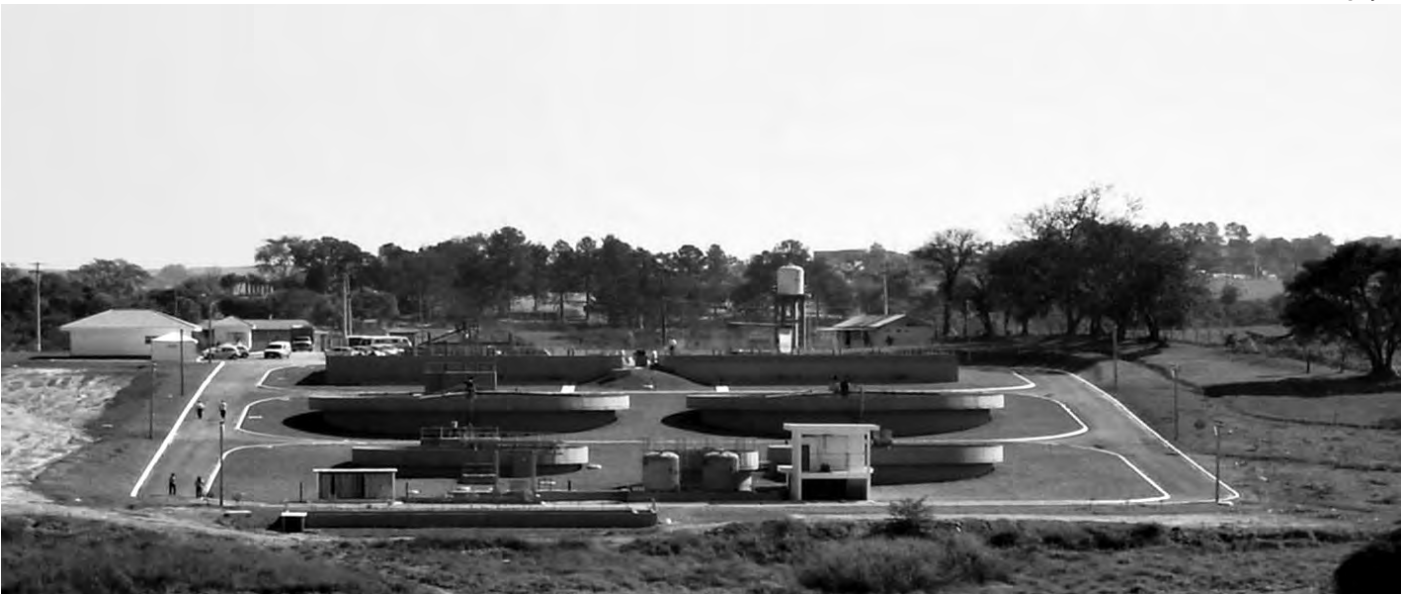
ETE XYKO DO SAAE. Ela receberá equipamento para medir com mais precisão o volume de esgoto
