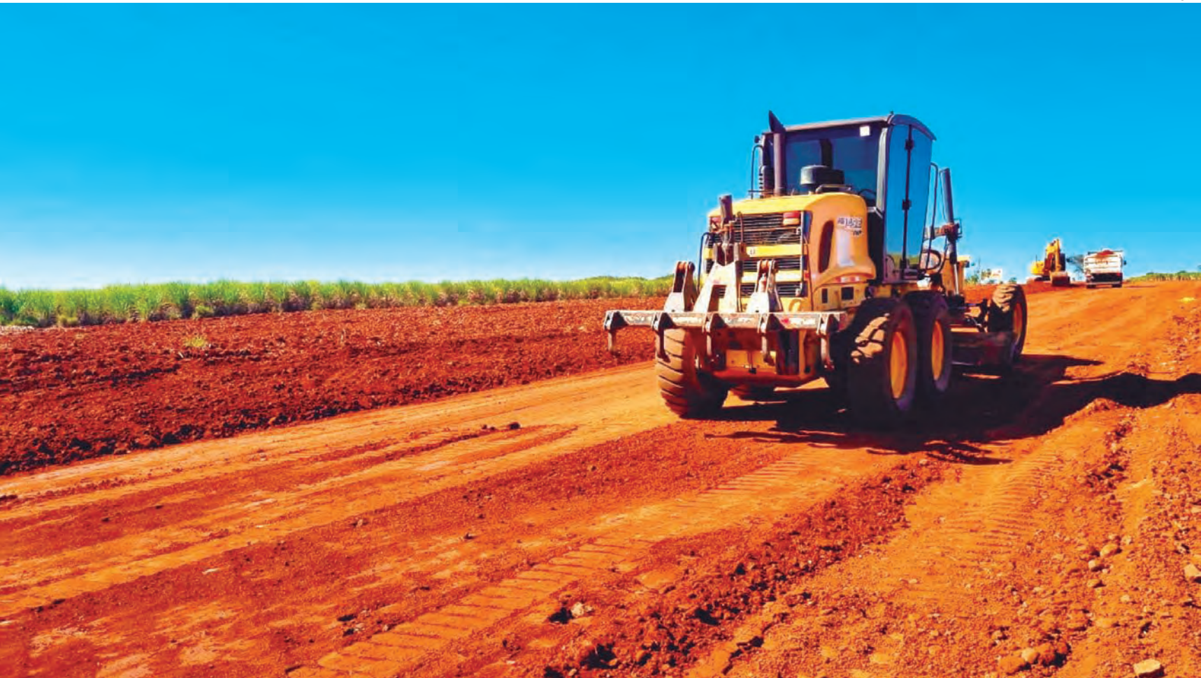
ASFALTO NA CAIC. Nesta quarta-feira (30) teve início os trabalhos para o asfaltamento da estrada municipal da Agrovila CAIC. A Prefeitura vai pavimentar dois quilômetros de estrada. O serviço começou pela limpeza, nivelamento e compactação do solo. O asfaltamento vai beneficiar a muitos moradores daquela região da zona rural.
