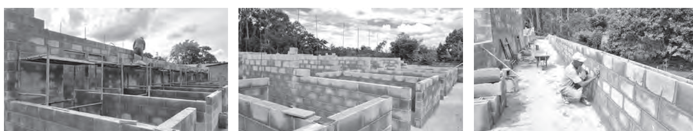
NOVO CANIL. A construção do Canil Municipal segue em ritmo acelerado. Aproveitando os períodos em que as chuvas pararam, as equipes continuaram a levantar as paredes das baias. A obra avançou, apesar das fortes chuvas que atingiram a cidade nesta semana. Nas novas instalações também funcionará o Centro de Controle de Zoonoses
