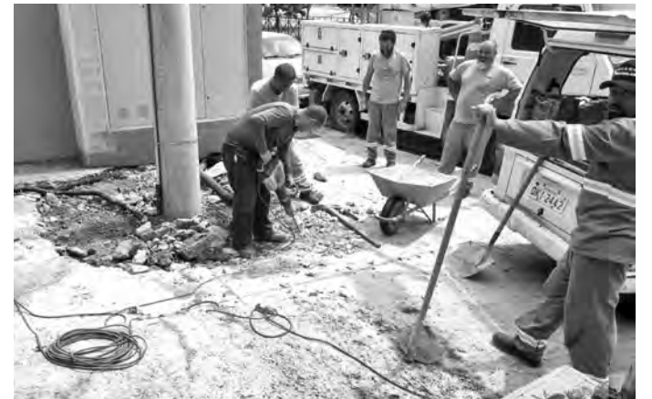
LIGANDO A ENERGIA. Um dos últimos serviços ainda pendentes foi executado nesta semana
