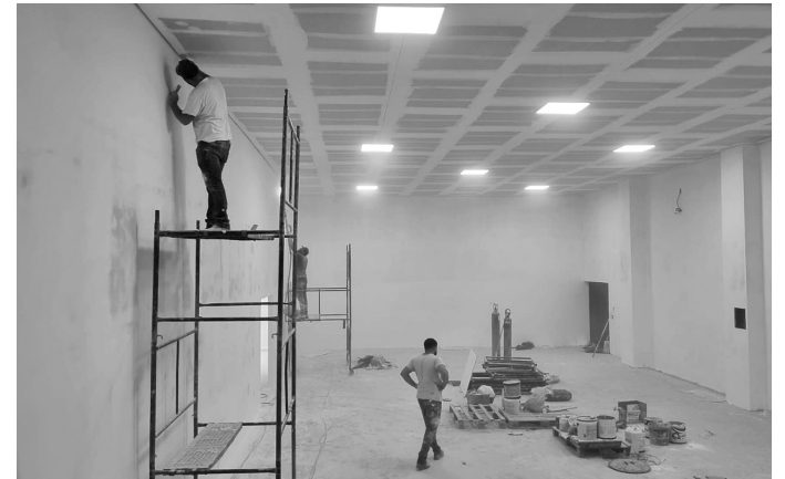
TRABALHO NÃO PARA. Equipe aplica massa corrida
