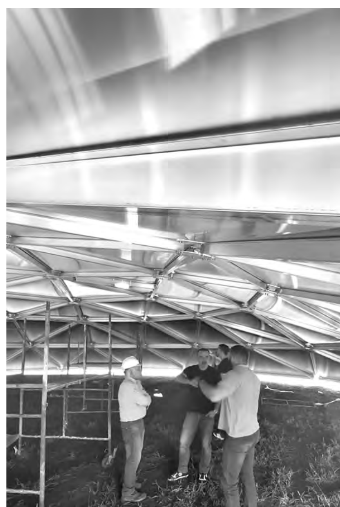
MUDANÇA. Porto Feliz está trocando a matriz de abastecimento de água para garantir o fornecimento
