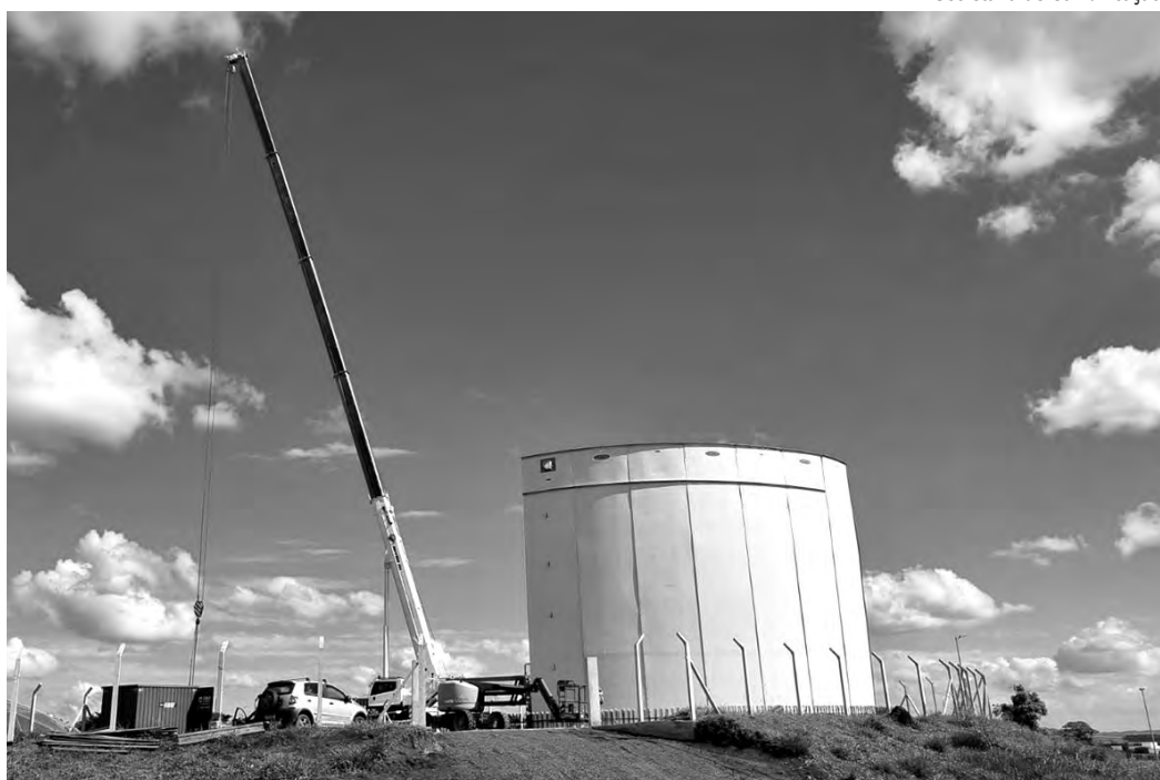
EM MONTAGEM. Um guindaste está sendo usado para movimentar as placas
