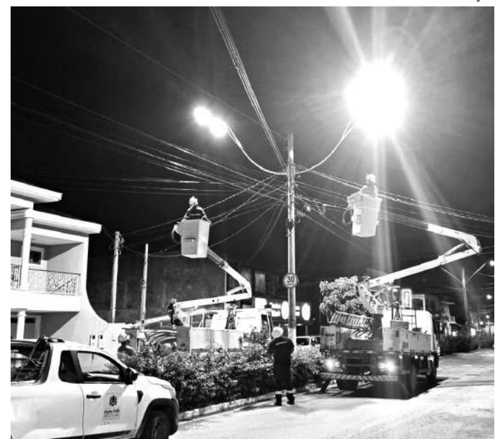
MAIS LUZ, MAIS SEGURANÇA. Nesta semana foi finalizada a instalação de braços duplicados e lâmpadas de LEDs no canteiro central da Avenida Getúlio Vargas (Bambu). Com os braços duplicados, os moradores, motoristas e pedestres têm mais segurança. A iluminação reforçada também está sendo instalada na Rua João Thomaz de Almeida (Jardim Bela Vista). A instalação de braços duplos de iluminação vai acontecer nas principais avenidas da cidade.
