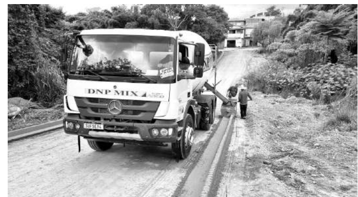
QUASE PRONTA PARA O ASFALTO. A Prefeitura vai asfaltar a Rua Alcides Costa Aranha, que liga o Bambu ao Jardim Bela Fonte. Nesta semana as equipes reciclaram e prepararam o solo, e também construíram as guias. Anteriormente, a rua foi nivelada e aterrada. As equipes também construíram o sistema para escoamento de águas de chuva. Falta pouco para a rua ser asfaltada, dando maior conforto e segurança aos muitos moradores que usam a Alcides Costa Aranha.
