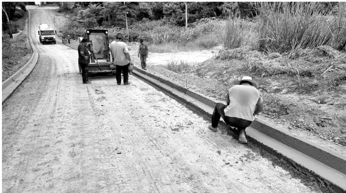
QUASE PRONTA PARA O ASFALTO. A Prefeitura vai asfaltar a Rua Alcides Costa Aranha, que liga o Bambu ao Jardim Bela Fonte. Nesta semana as equipes reciclaram e prepararam o solo, e também construíram as guias. Anteriormente, a rua foi nivelada e aterrada. As equipes também construíram o sistema para escoamento de águas de chuva. Falta pouco para a rua ser asfaltada, dando maior conforto e segurança aos muitos moradores que usam a Alcides Costa Aranha.
