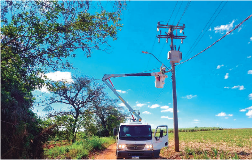
LÂMPADAS DE LED NA ZONA RURAL. A Secretaria de Serviços Públicos está intensificando os trabalhos de instalação de braços e leds na zona rural do município. Nesta semana teve início a instalação no bairro Caiacatinga (foto). Vários bairros da zona rural já receberam este benefício. Os braços e leds que estão sendo instalados na zona rural são aqueles retirados das avenidas da cidade, que ganharam braços duplicados. Na área urbana, a iluminação pública de Porto Feliz já é feita 100% com lâmpadas de LED. Este tipo de lâmpada, que fornece maior luminosidade com menor consumo de energia, está chegando também aos bairros rurais.
