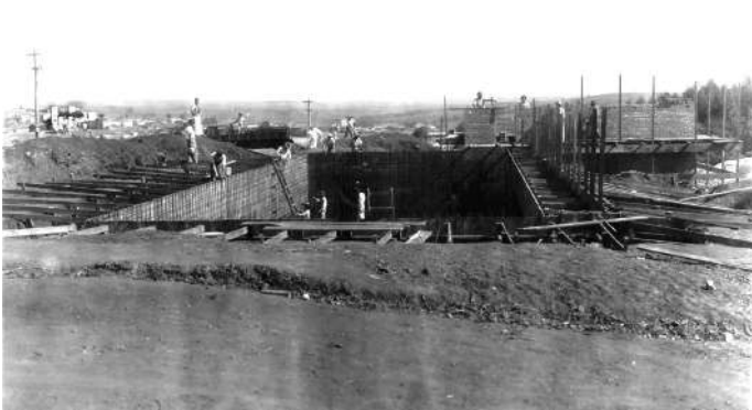
A CIDADE EM OBRAS. A partir do alto, a abertura da estrada de Sete Fogões, a estação de tratamento de água e a ponte para Vila Progresso
