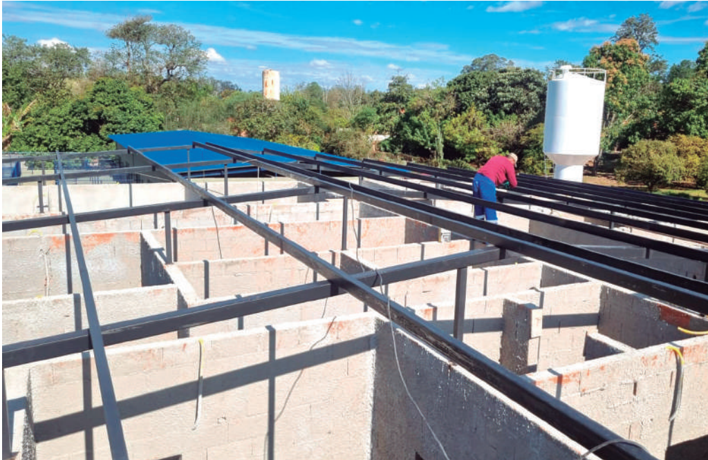
BEM-ESTAR ANIMAL. As obras no novo Centro de Controle de Zoonoses, Canil e Clínica Veterinária avançam. Nesta semana, as estruturas metálicas foram montadas
