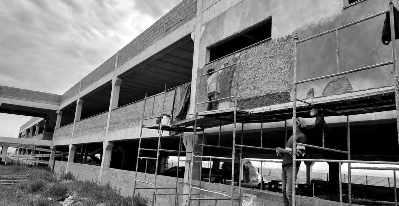
MAIS DE 6 MIL METROS DE ÁREA CONSTRUÍDA. Equipes estão rebocando as paredes externas e internas
