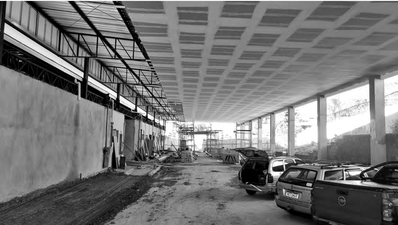
NOVO ESPAÇO. A área entre o Terminal e o Estádio dos Bambuais foi coberto e já recebeu o forro
