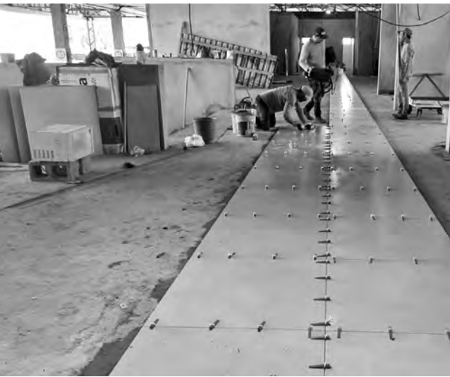
NESTA SEMANA. As equipes assentaram pisos e azulejos em nova etapa da obra
