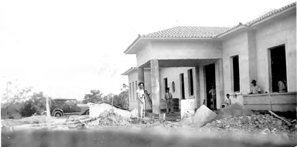
NOVAS INSTALAÇÕES. Um registro da construção em terreno doado por Antônio Bello
