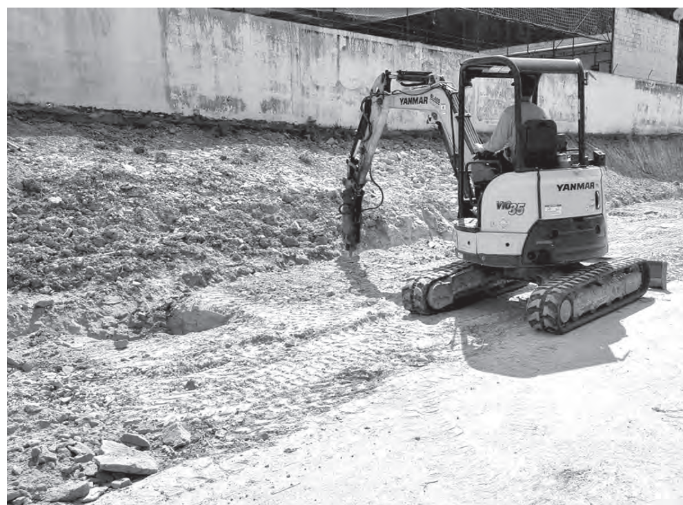
TERRAPLENAGEM. Muita terra teve de ser retirada para preparar o terreno
