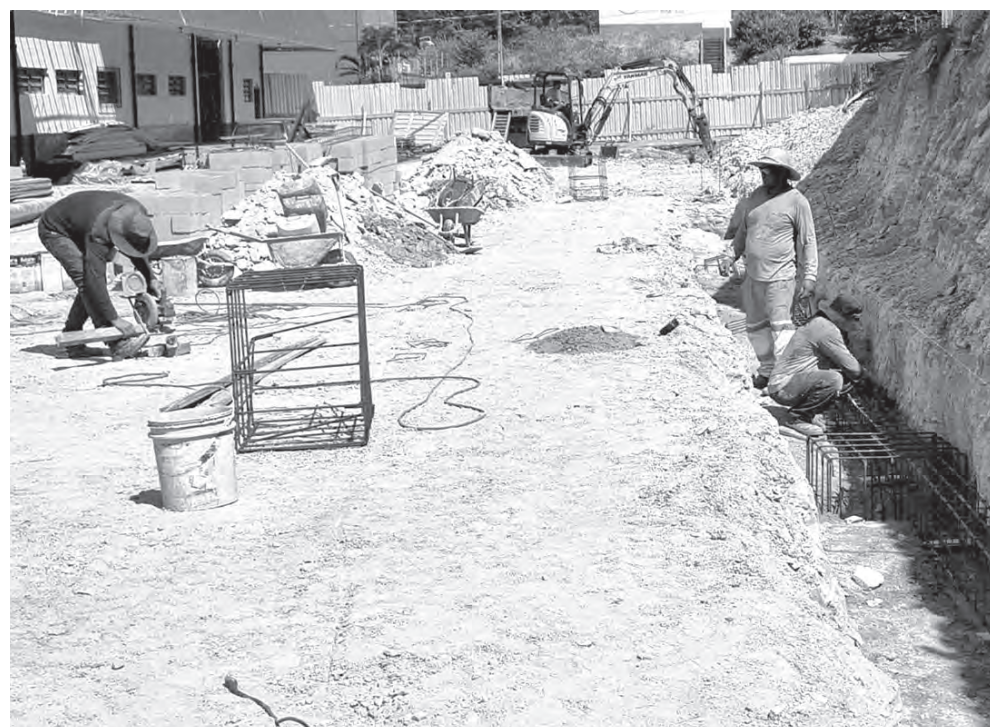
TRABALHO INTENSO. As obras também estão acontecendo na antiga praça
