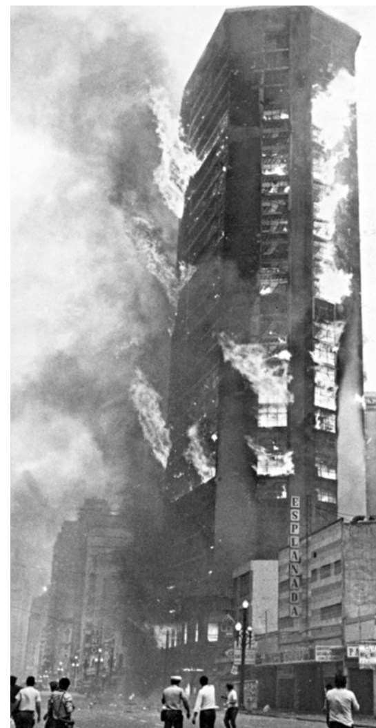
EDIFÍCIO ANDRAUS. O incêndio em 1972 contribuiu para a criação de uma estrutura permanente de Defesa Civil no Estado
