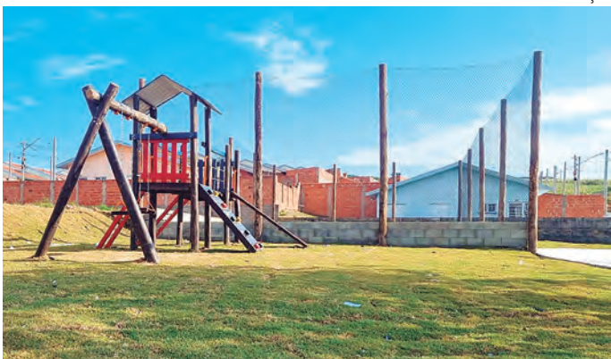
A Secretaria de Serviços Públicos colocou a grama, construiu calçadas instalou brinquedos de madeira (Casa do Tarzan) e concluiu a quadra de areia em Altos do Jequitibá
