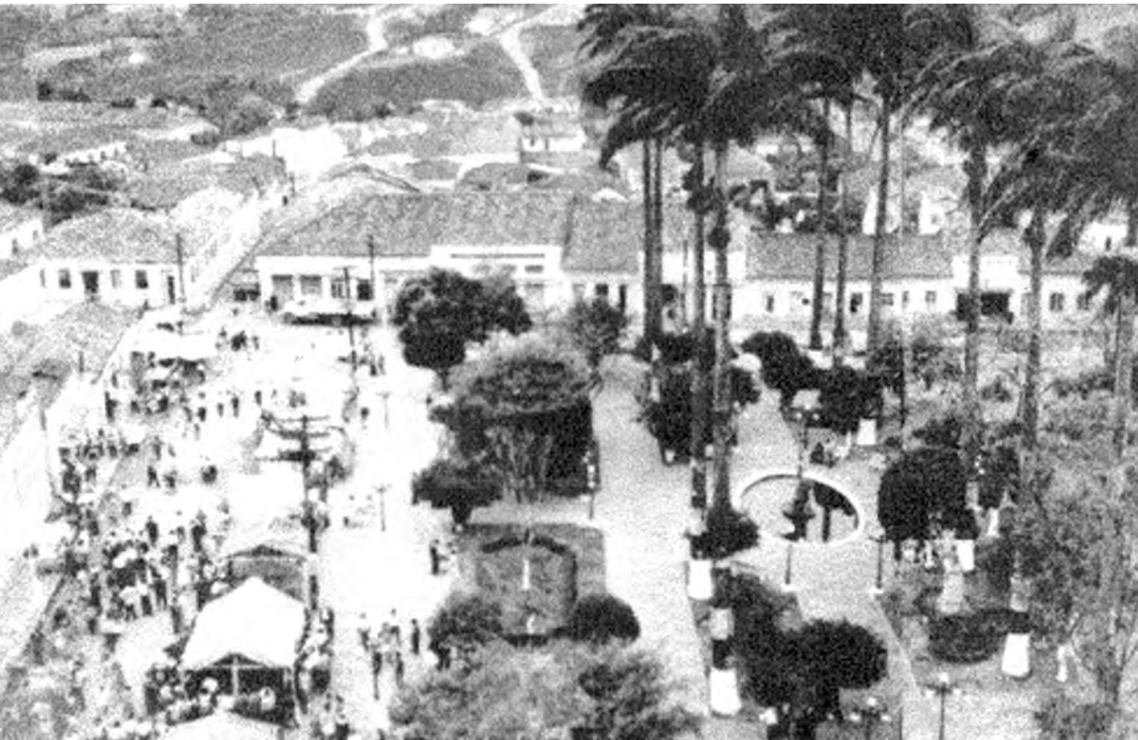
QUINZE ANOS DEPOIS. A Praça da Matriz em dia de festa. As barracas já eram instaladas no local aonde até hoje se montam os palanques em dias de desfile. Neste registro de 1935, as palmeiras já cresceram, o traçado do jardim mudou e é possível ver o chafariz
